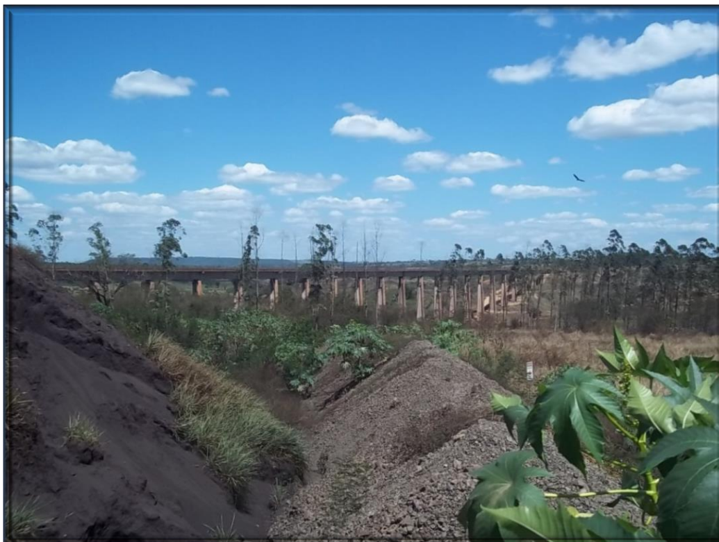
FOTO 3 – “Isolamento” dos Resíduos de Minério
