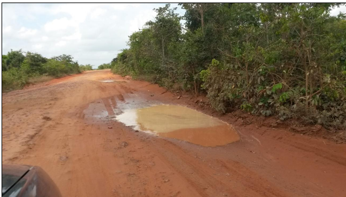
Figura 2 -Via de acesso para o PASJMA
