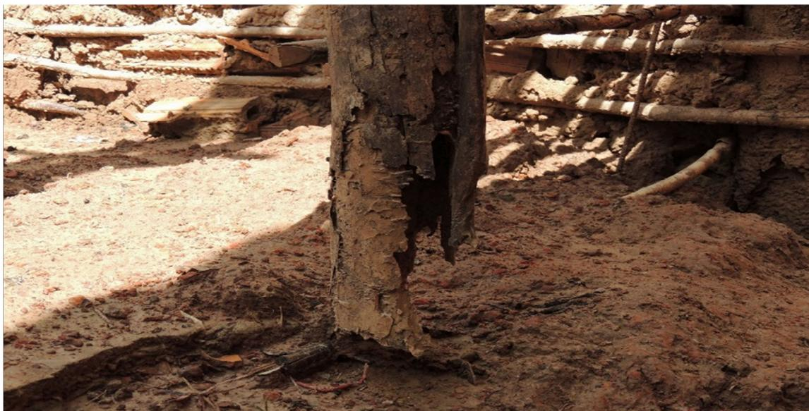
Foto 16: Madeira corroída pela umidade da terra.
