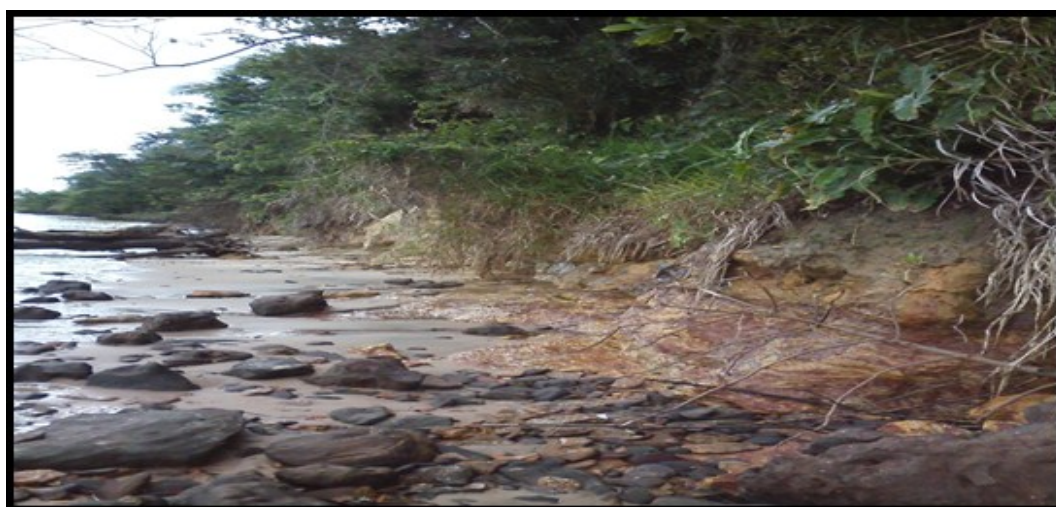
Figura 02-Processo erosivo causado pelas Marés na Praia de Jacamim Fonte- Dias (2015)
