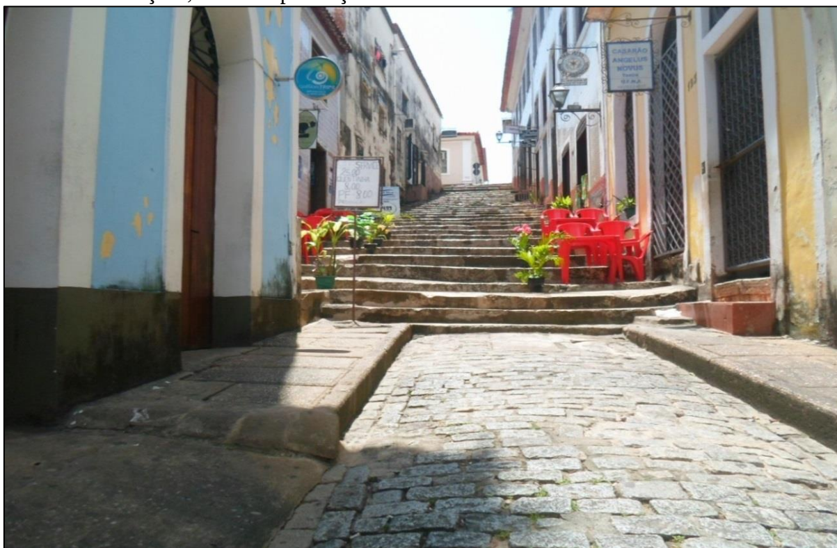
Figura 45: Rua inacessível para pessoas com deficiência, mesmo apresentando guia rebaixada na calçada, devido à presença de escadaria.
