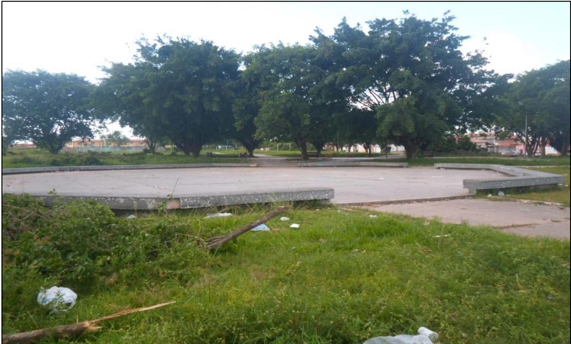
Figura 61: Praça pública apresentando sinais de má conservação.
