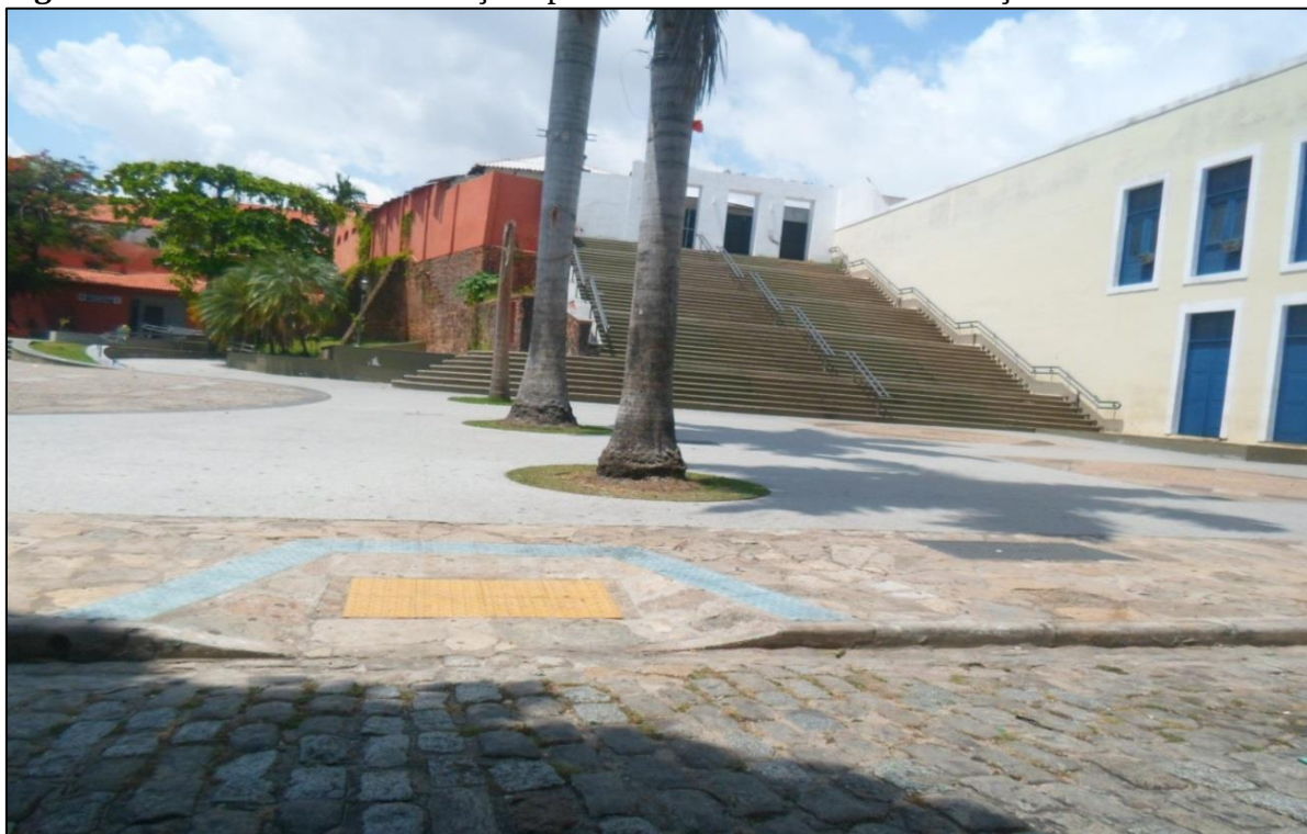
Figura 44: Guia rebaixada na calçada para acesso de cadeirantes à Praça Nauro Machado.
