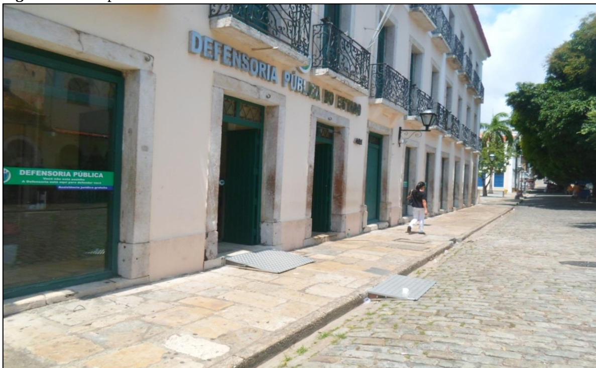
Figura 49: Rampa removível na entrada de acesso à sede da Defensoria Pública do Estado.
