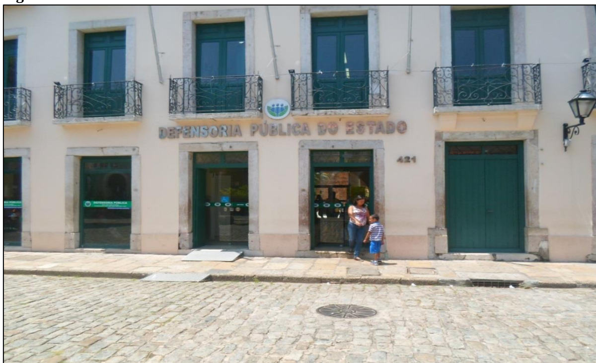
Figura 46: Sede da Defensoria Pública do Estado localizado na Rua da Estrela.
