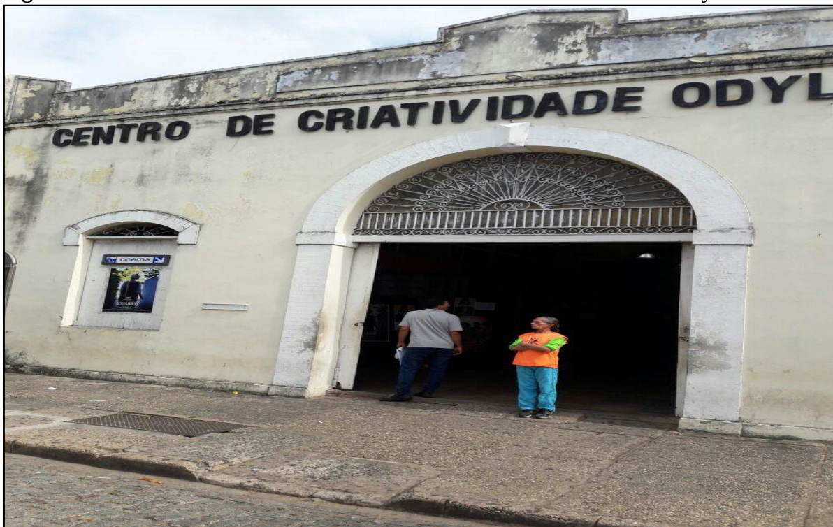
Figura 52: Guia rebaixada na entrada de acesso ao Centro de Criatividade Odylo Costa Filho.
