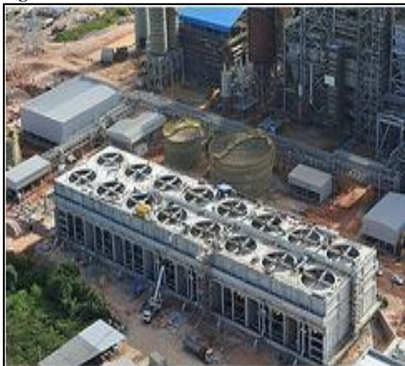
Figura 06: Torre de resfriamento da UTE
