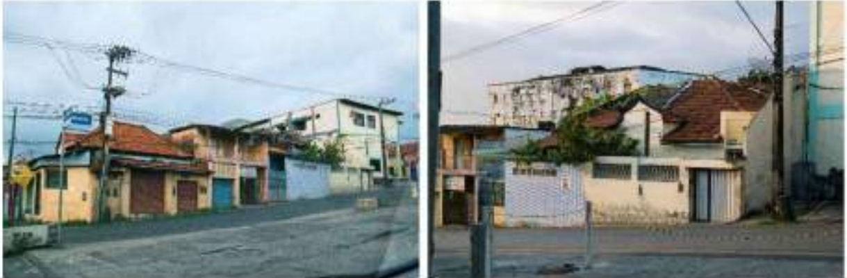
Figura 9 - Aparência atual da quadra na rua das Cajazeiras, entre a Rua do Norte e Rua do Passeio, onde foram edificadas as casas da Empresa Constructora Limitada.
