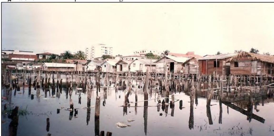
Figura 32: Retirada das palafitas da Lagoa da Jansen. 1992.
