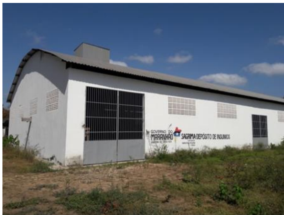
Figura 20 - Depósito para armazenamento de insumos, área externa.
