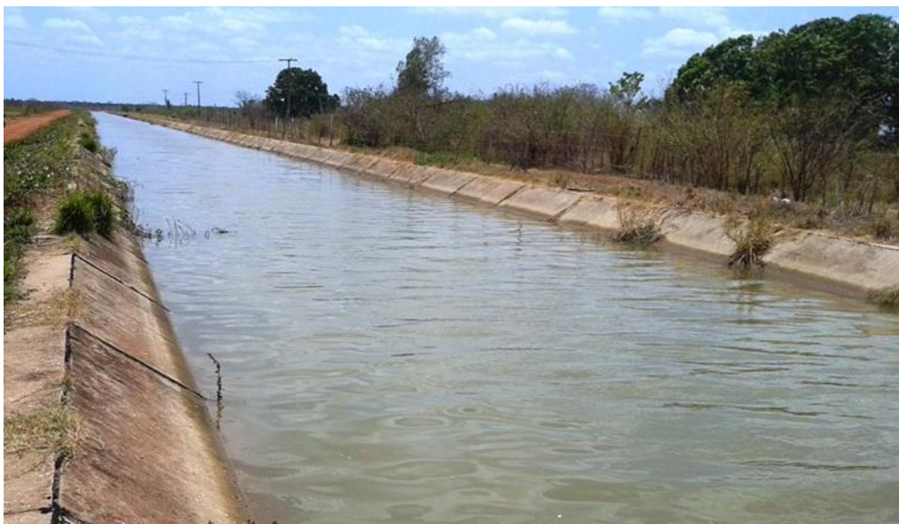
Figura 23 - Canal de irrigação principal
