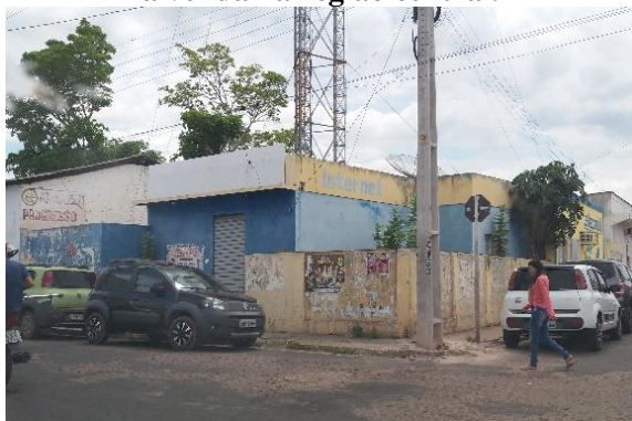
Figura 26 - Chapadinha. Edificação comercial à venda na região central.
