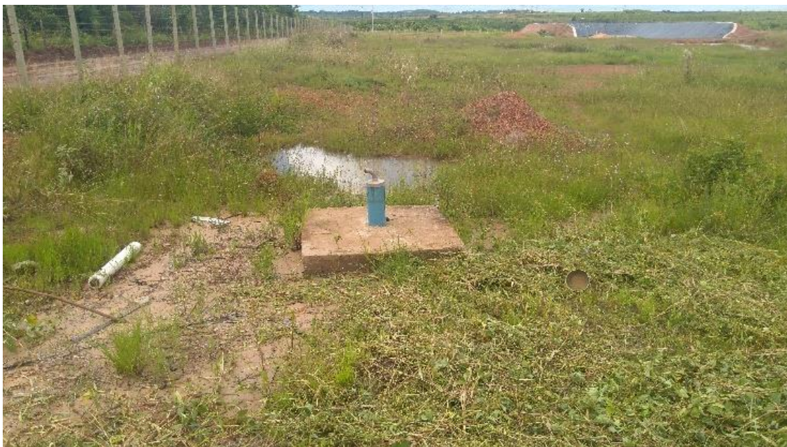
Figura 27: Poço artesiano para abastecimento do setor administrativo
