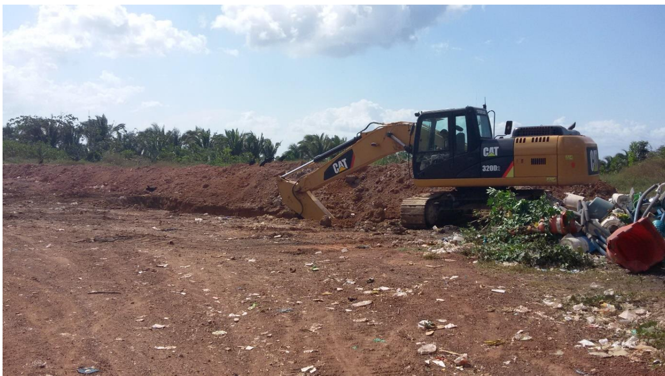
Figura 18: Trator abrindo vala para aterrar o resíduo sólido em Bacabeira - MA.
