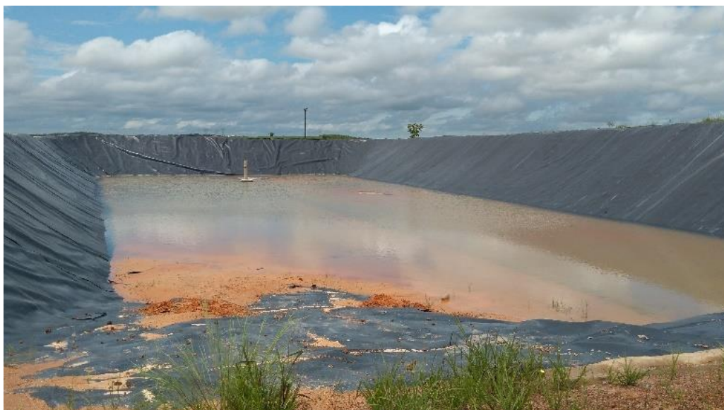
Figura 29: Manta de impermeabilização na cova da obra entregue a prefeitura.
