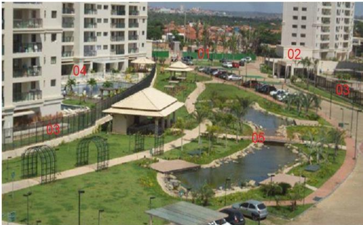
Figura 2: Condomínio Jardins – Condomínios dentro de um condomínio.
