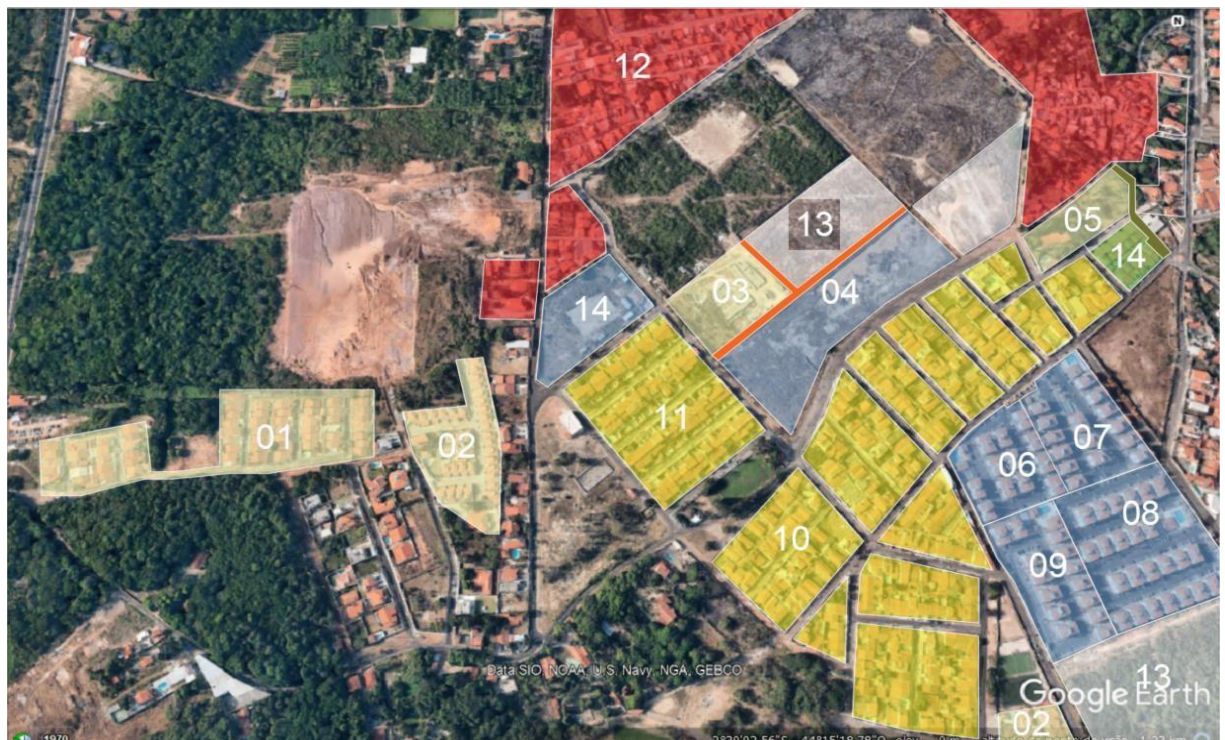
Figura 27: Adensamento por enclaves urbanos em São Luís, bairro Planalto Vinhais II.
