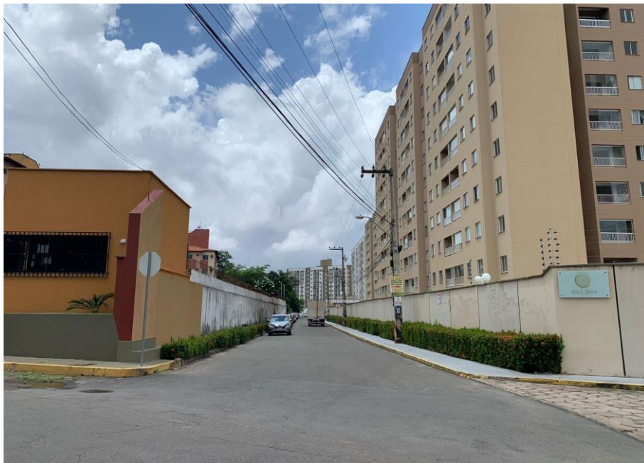
Figura 24: Rua enclavada por condomínio, entrada do 3D Tower.
