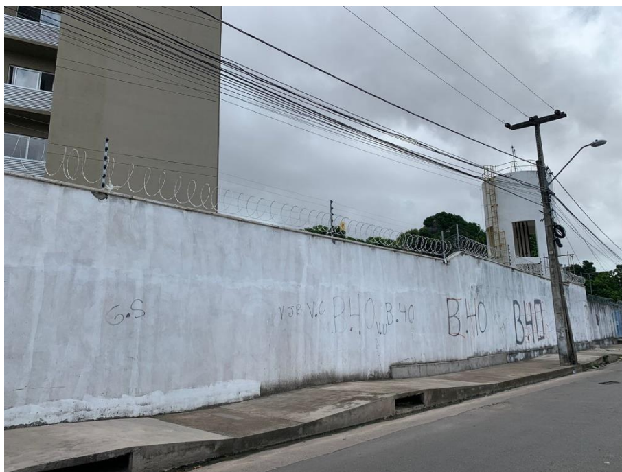
Figura 25: Área de recolhimento dos resíduos sólidos e coleta de lixo na Rua Retiro Natal, fundos do 3D Tower.
