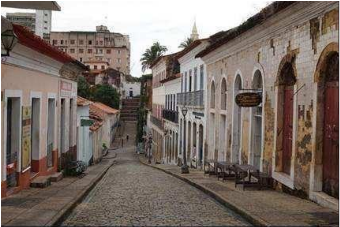
Foto 1 - Calçadas no Centro Histórico de São Luís com a mesma inclinação que a rua
