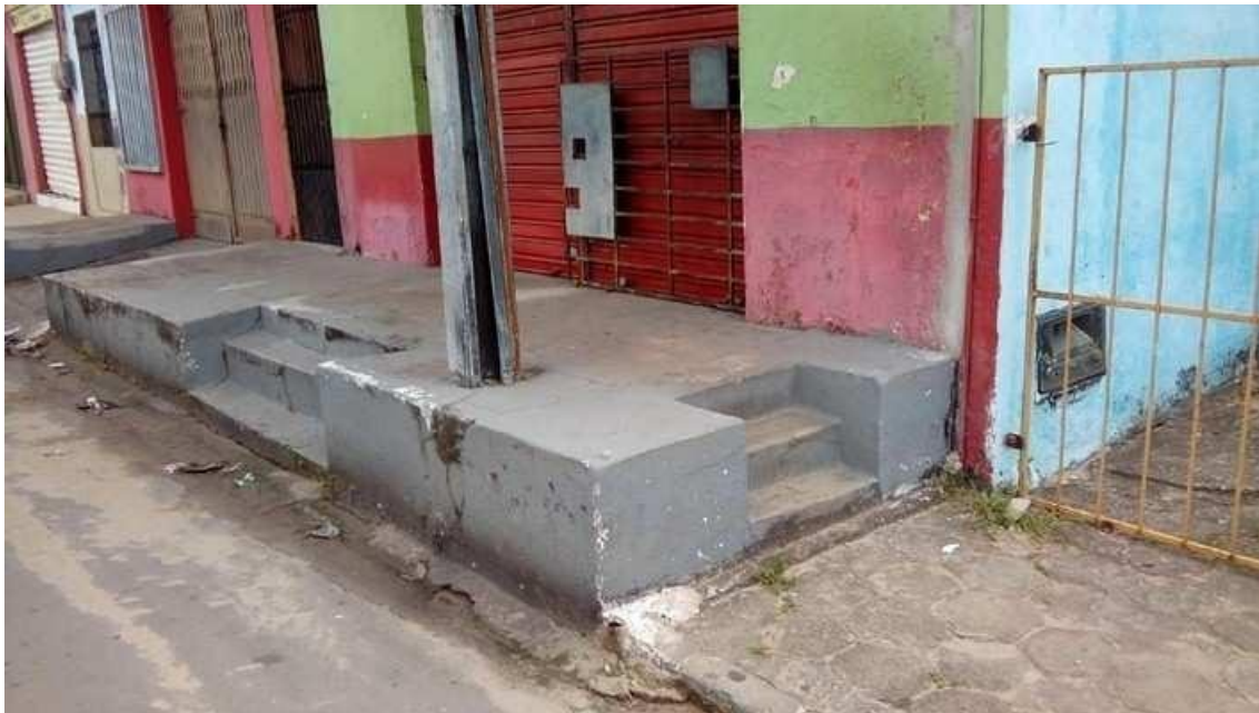
Foto 6 - Bairro Cohatrac. Escadaria na calçada
