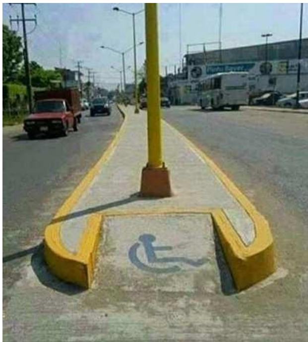
Foto 12 - Rampa na calçada em frente ao poste
