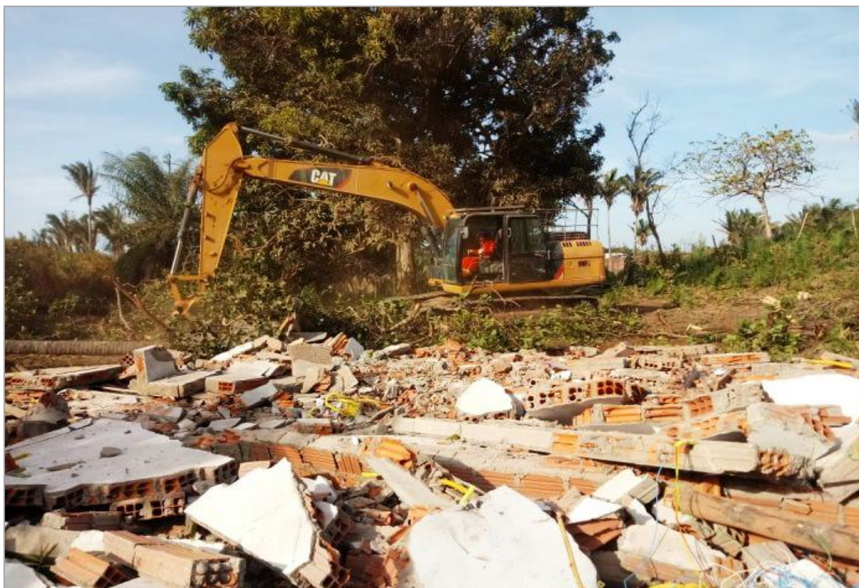
Figura 28 – Demolição de casas na comunidade do Cajueiro, São Luís-MA
