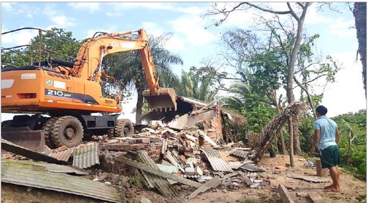
Figura 7 – Cajueiro, São Luís-MA: demolição de moradia em área reclamada pela empresa
