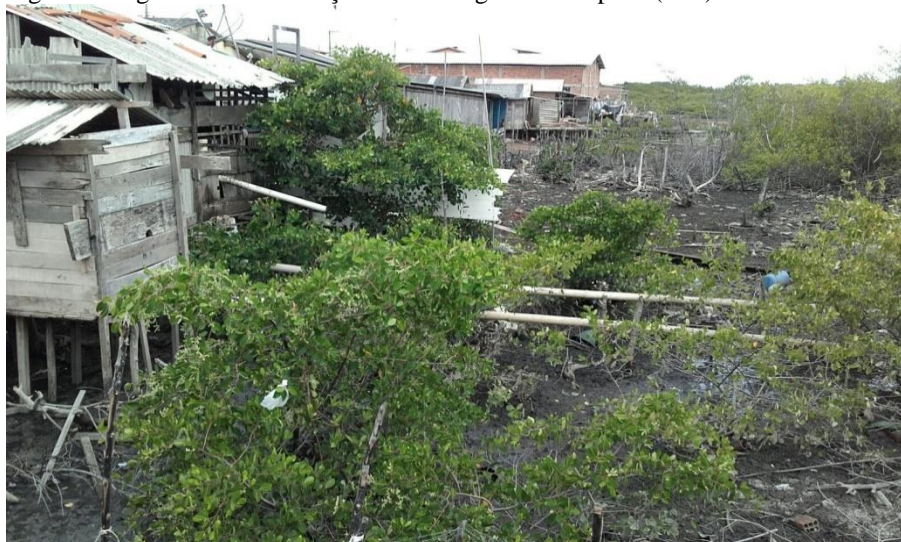
Figura 9: Esgoto in natura lançado nos manguezais. Raposa (MA)
