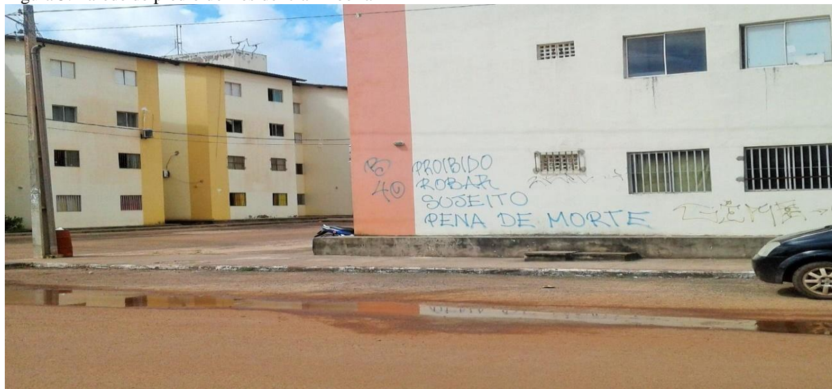
Figura 5: Parede de prédio do Residencial Ribeira
