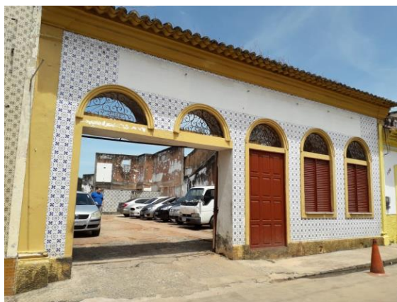
Figura 1 – Casarão descaracterizado na Rua dos Afogados
