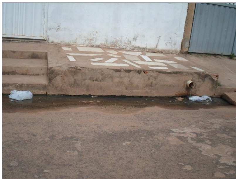
Figura 02: Lançamento de esgoto doméstico in natura .
