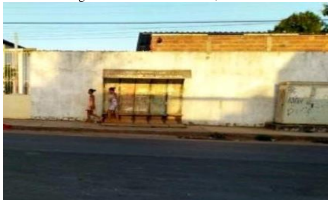
Figura 4: Parada inacessível, Av. Dois
