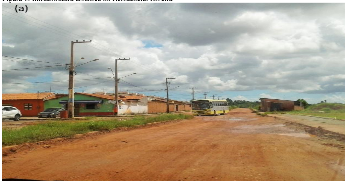
Figura 6: Infraestrutura asfáltica no Residencial Ribeira
