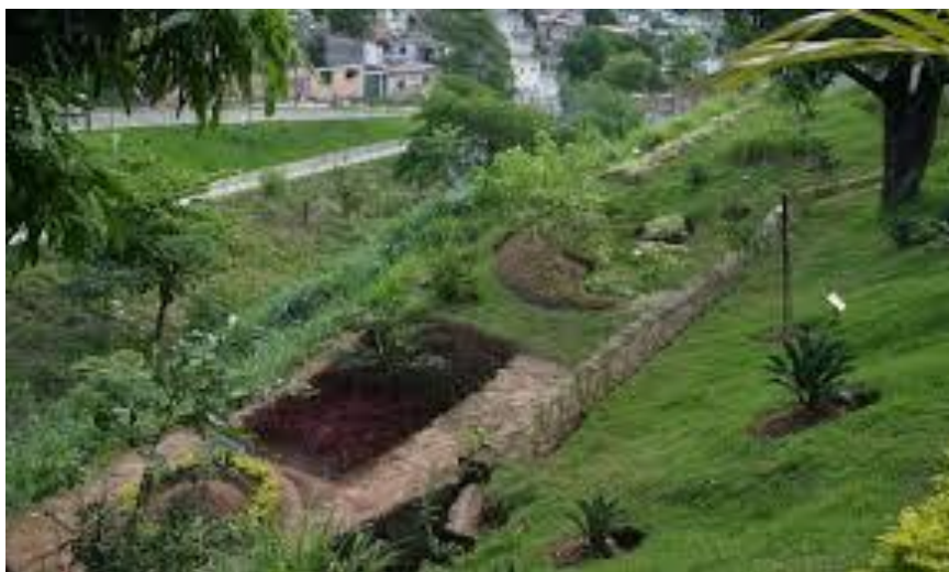
Figura 3: intervenção de drenagem em sistema não estrutural em Belo Horizonte
