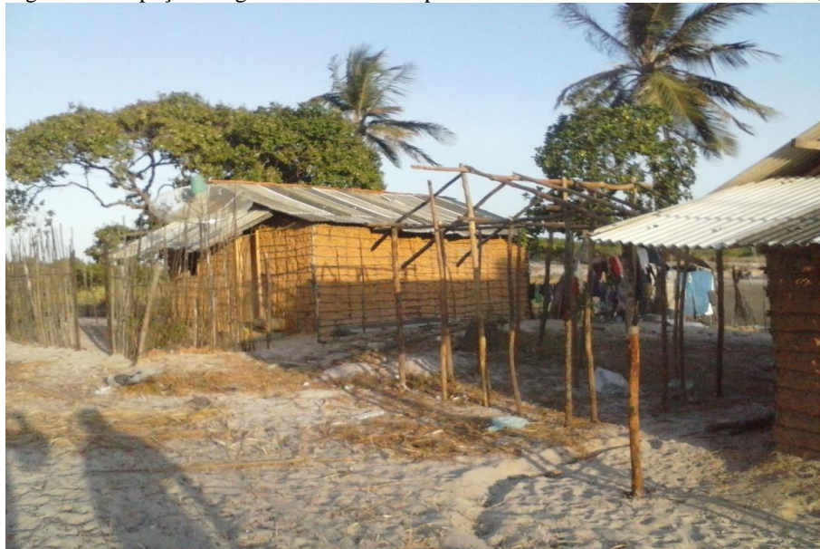
Figura 6: Ocupação irregular em área de depósito de sedimentos arenosos. Ilha Bela, Raposa (MA)
