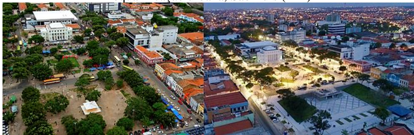
Figura 1- Vista aérea do Complexo Deodoro antes e durante o processo de requalificação urbana, São Luís (MA)
