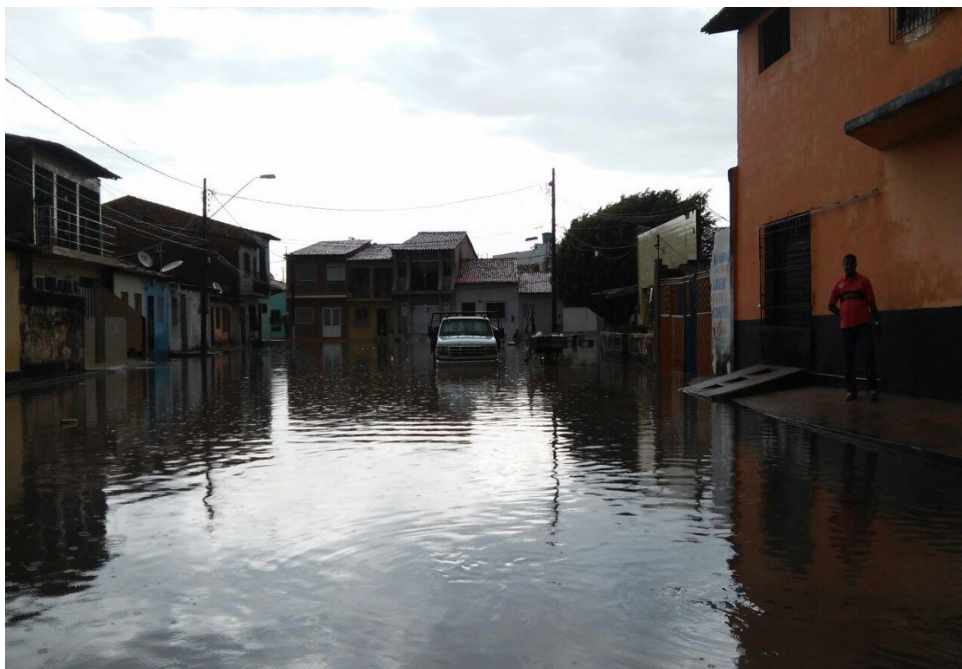
Figura 06: Área residencial e comercial afetadas pela falta de drenagem no bairro
