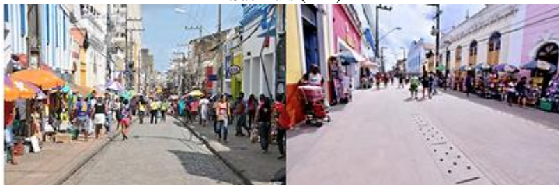
Figura 2- Rua Grande antes e durante o processo de requalificação urbana, São Luís (MA)
