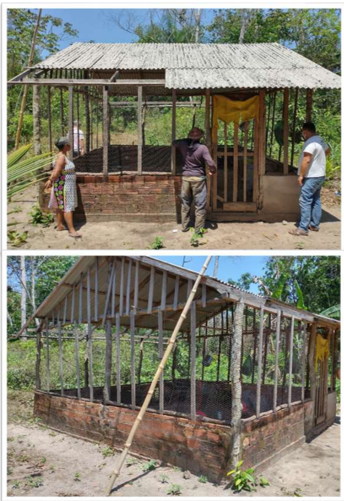
Figura 16. Galinheiro em construção FONTE: Pereira 2021
