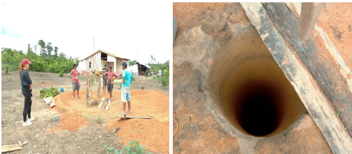
Figura 11 e 12: Perfuração do poço no acampamento
