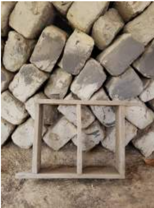
Imagem 05 – Forma de adobo e tijolos de adobe armazenados no alpendre
