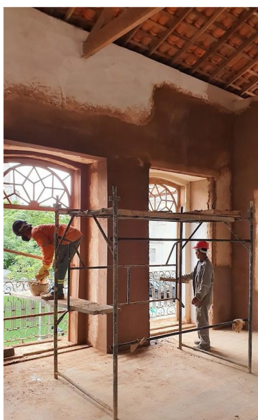
Figura 41 - Imagem do restauro do Centro Caixeiral.
