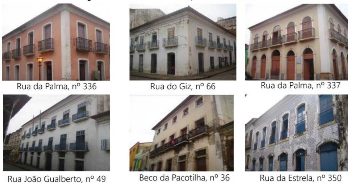
Figura 34 - Imóveis do estado para fins habitacionais
