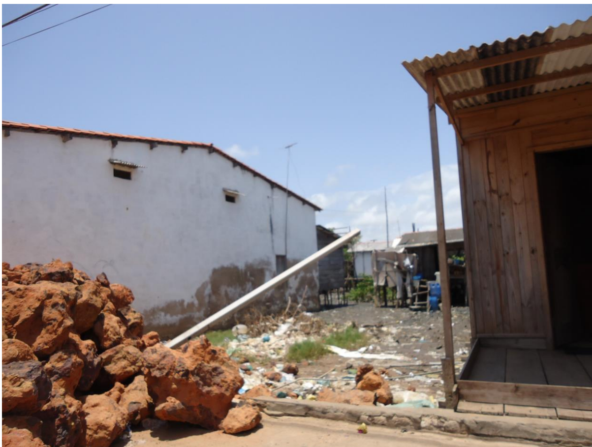
Foto 6 - Sub-moradia no município de Raposa-MA.
