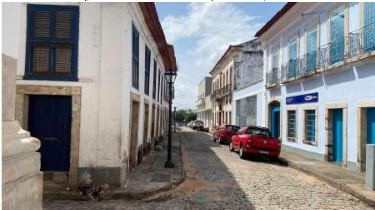
Figura 112 – Rua da Estrela – dia 09 de janeiro de 2025, às 10h16.
