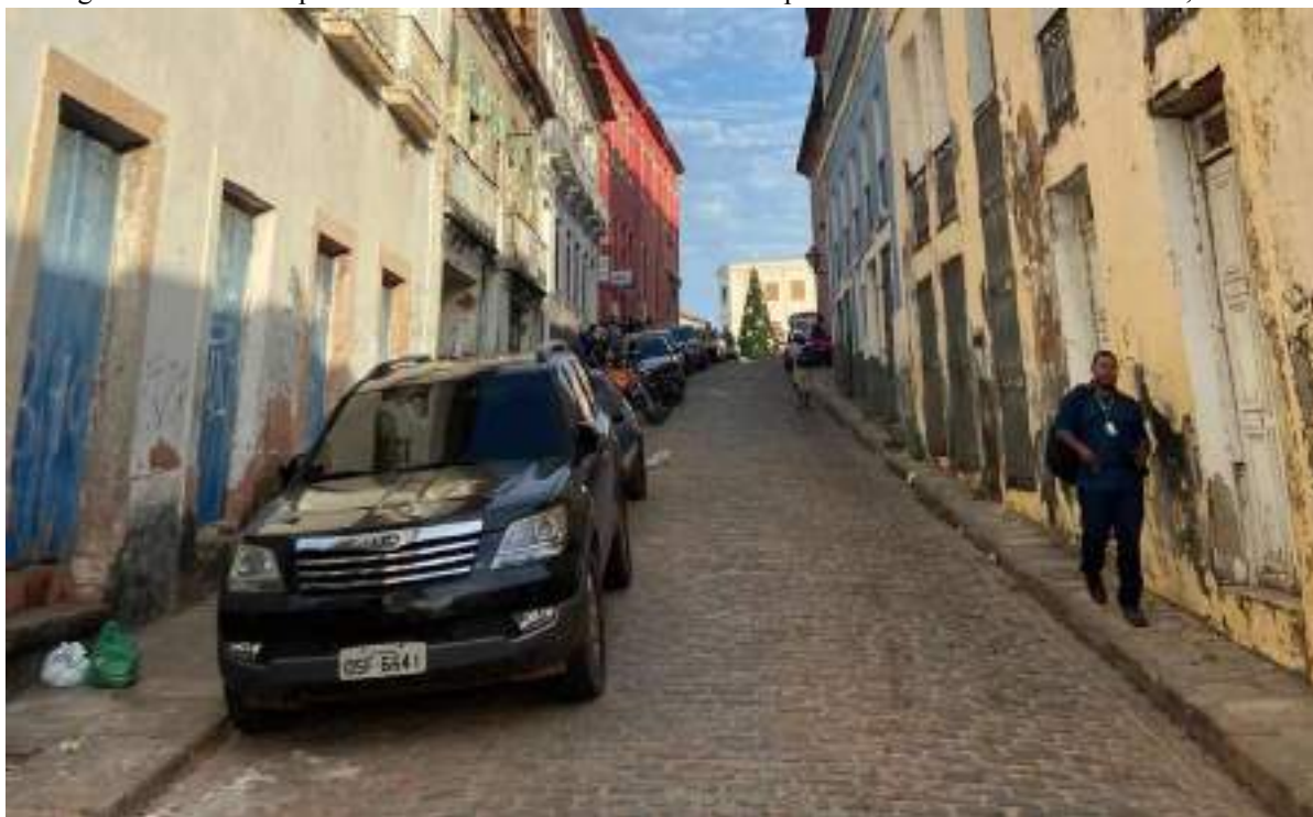
Figura 77 – Vista da parte mais alta da Rua Humberto de Campos – dia 11 de dezembro de 2024, às 17h.
