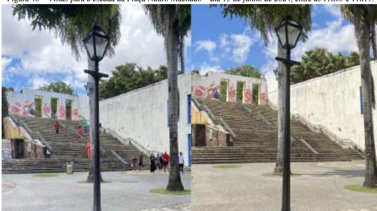
Figura 48 – Vistas para a escada da Praça Nauro Machado – dia 15 de junho de 2024, entre as 11h05 e 11h19.
