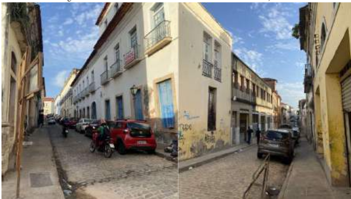
Figura 76 – Vistas da Rua da Palma – dia 11 de dezembro de 2024, às 17h.
