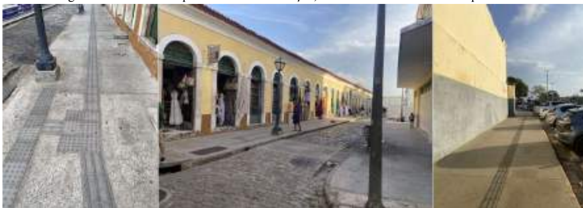
Figura 26 – Trechos do perímetro de intervenção, mostrando faixas elevadas e pisos táteis.
