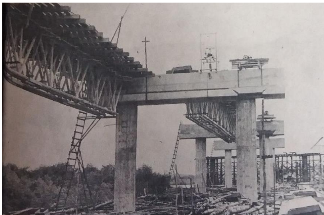
Figura 17 - Construção da Ponte Bandeira Tribuzi.
